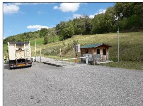
*Pont-bascule et contrôle de la radioactivité*
